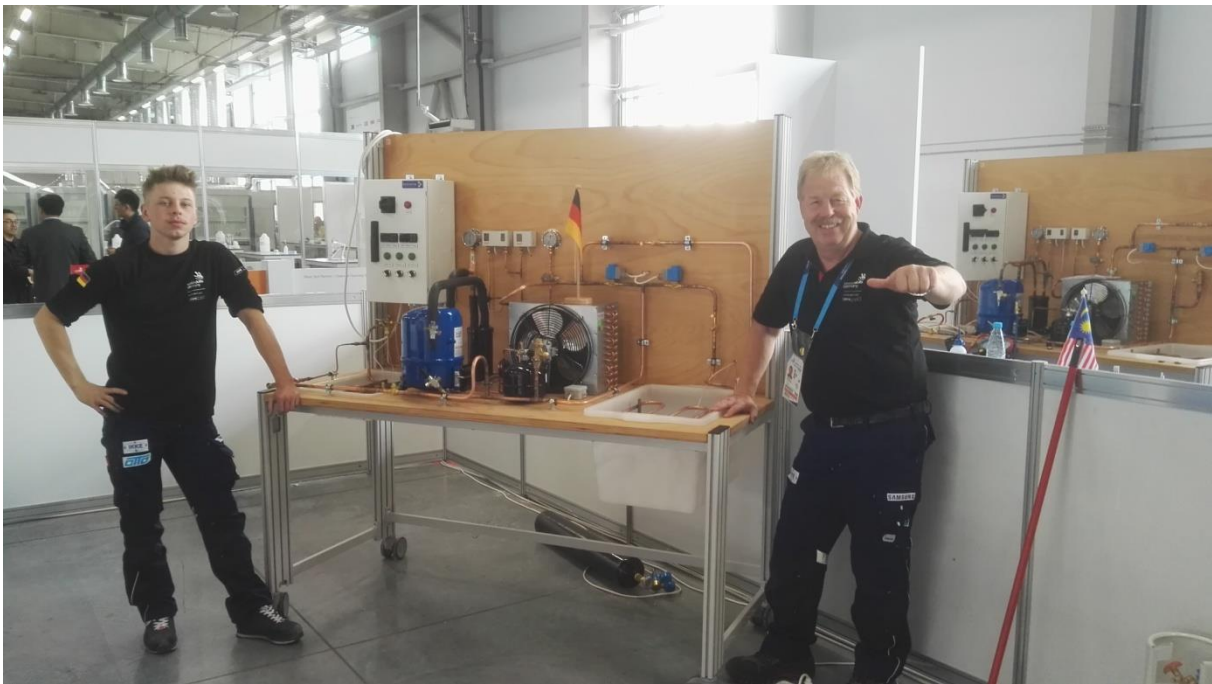
Lukas Brenne und Karsten Beermann mit gebauter Kälteanlage
